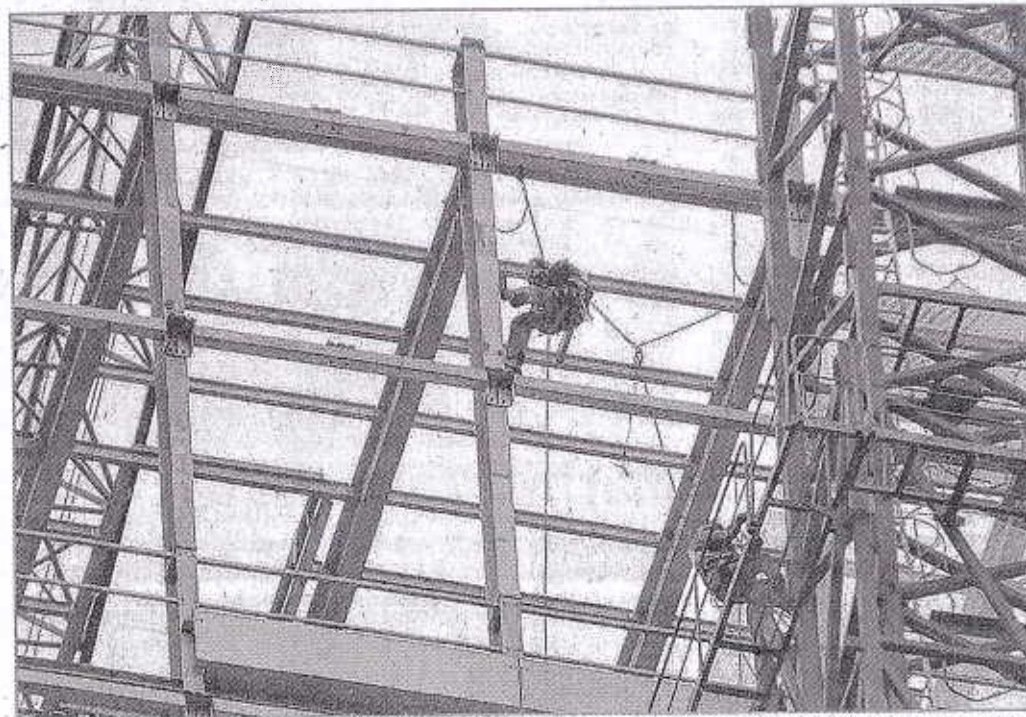
Framatec travaille actuellement sur le chantier de la tour Incity à Lyon. Un édifice de 200 mètres de haut qui sera livré en juin 2015. (Photo DR)
